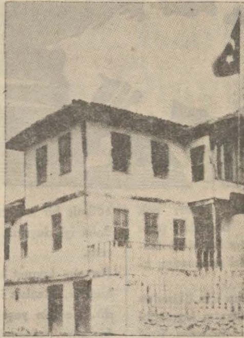
Kızılcahamam'da Belediye Binası güzel bir hâl yapılmaktadır. Buraya sarfedilecek paranın karşılığı bulunmuştur.
